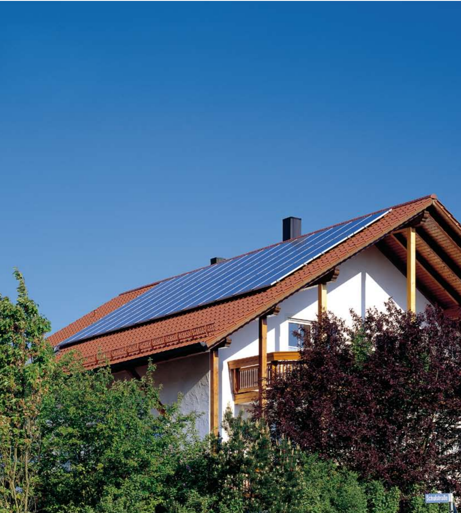
Einfamilienhaus Schelldorf, Leistung: 5,88 kWp
